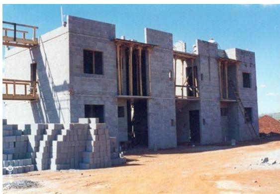
**Figura 1.** Bloco alvenaria estrutural concreto. Fonte: Iporã, 2016. **Figura 2.** Bloco alvenaria estrutural concreto. Fonte: Iporã, 2016.
